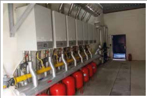
Resim 5: Kaskad sisteminin 50.000 m³/h RM/A istasyonunda uygulanması
