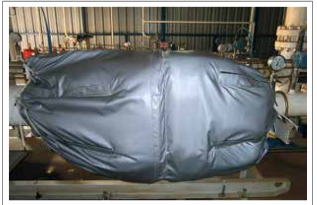
Resim 6: Regülatör ısıtıcı ceket
