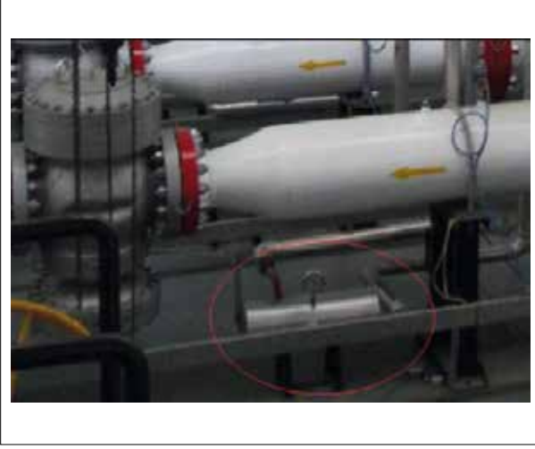
Resim 7: Pilotların ısıtılması için ayrı bir eşanjör kullanımı
