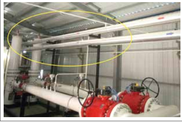
Resim 4: Eşanjörlere giden boruların yalıtılması
